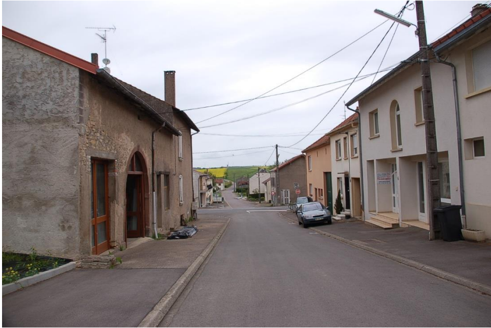
PHOTO 13 : VUE DE LA RUE DE LA FORET VERS LA RUE DE L'ABBE SIMMINGER (RD 956)
