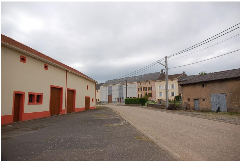
PHOTO 25 : FERMES RENOVEES EN 2016
