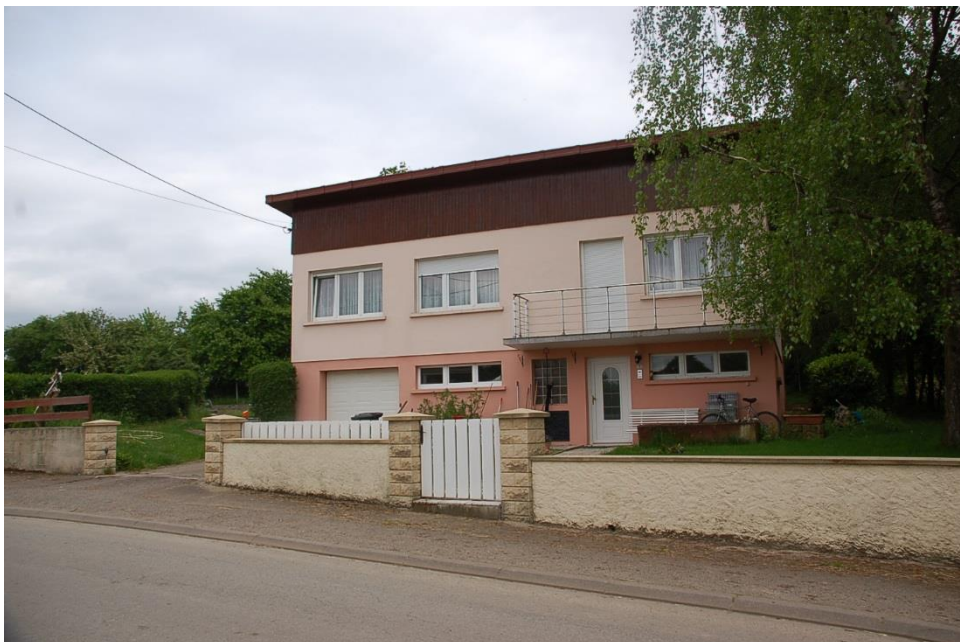
PHOTO 21 : PAVILLON DES ANNEES 1970-1980 ROUTE DE KIRSCH
