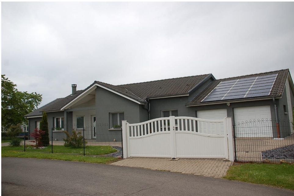
PHOTO 12 : PANNEAUX SOLAIRES SUR PAVILLON RECENT
