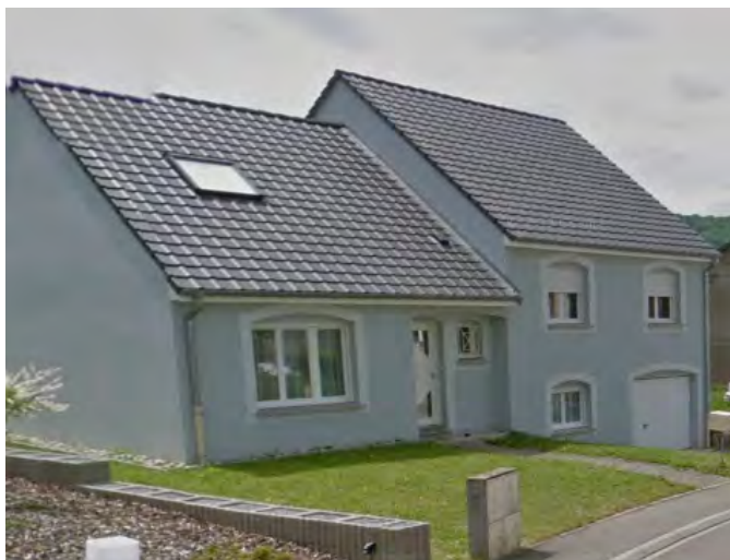
Toit à 2 pans avec faîtage parallèle à la rue, rue Gounod
