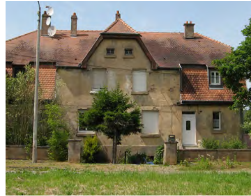
86-88 rue de la Gare : toiture à la Mansart, tuiles plates en écailles
