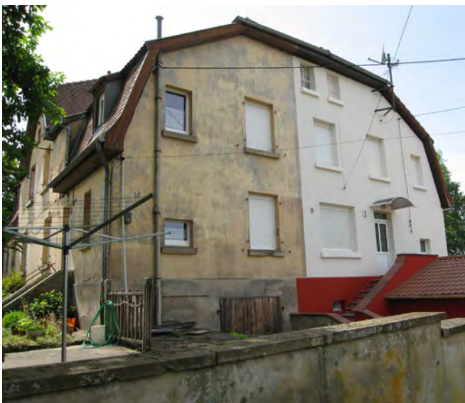
Habitat intermédiaire ancien, avec 4 accès indépendants
