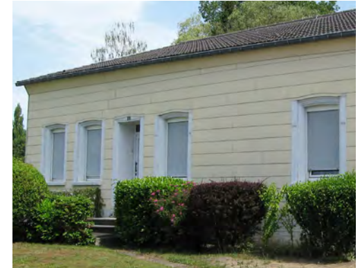
4 rue de la Roche Posay : de beaux encadrements finement sculptés qui mériteraient d'être dégagés
