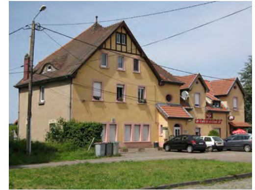
84 rue de la Gare : pans de bois, tuiles plates en écailles
