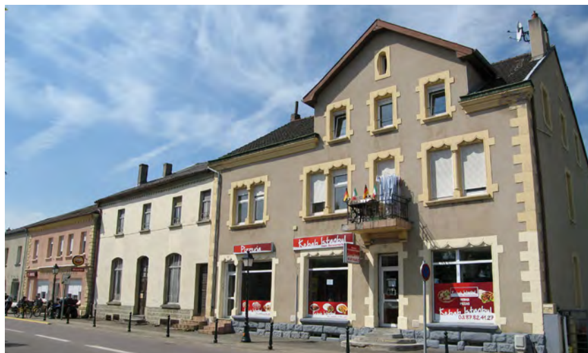
Maisons de ville en ordre continu avec commerces, rue de la Gare
