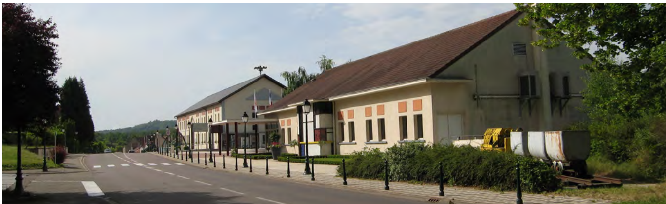
Parvis piéton de la salle des fêtes et de la mairie
