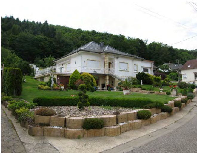
Toit à 4 pans principaux, rue Haute
