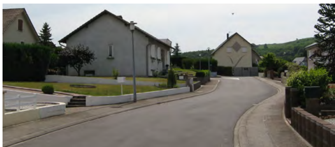
Voie de desserte d'un quartier résidentiel
