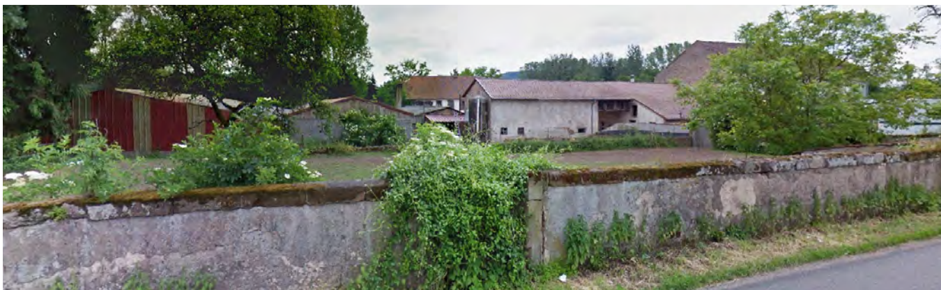
Domaine de La Forge : hangars métalliques et ancienne ferme en maçonnerie traditionnelle
