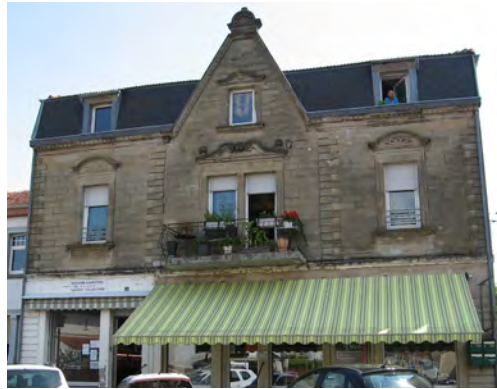
26 rue de la Gare, 1928 : façade en pierre de taille, décor néo-classique et «troubadour»
