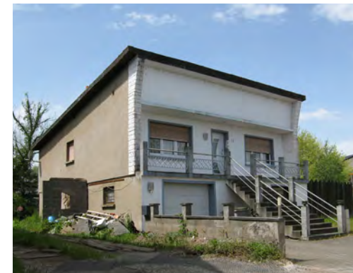
11 rue de la Roche Posay, années 1960. Toit à un seul pan donnant de la hauteur à la façade avant
