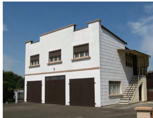
Ancien garage, 3 rue du Chemin de Fer, années 1950-60. Toit dissimulé derrière la façade-acrotère
