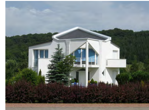
Villa face au collège, années 1990. La complexité des volumes contraste avec la sobriété des couleurs
