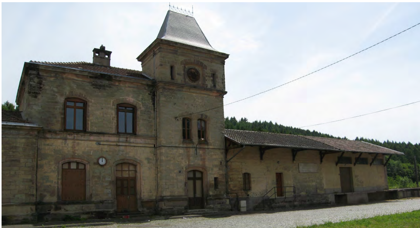
Ancienne gare, construite sous la première annexion allemande
