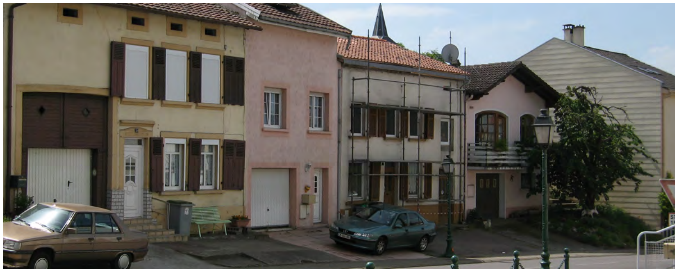
Bâti traditionnel rural en ordre continu avec usoir, rue Principale à Falck-Village
