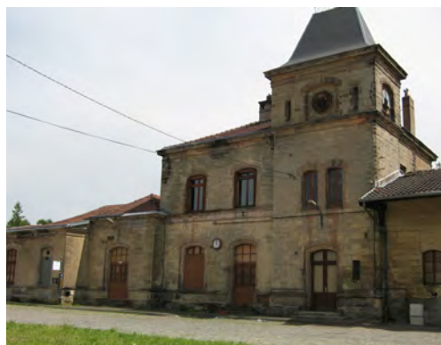
Ancienne gare édifée entre 1890 et 1904
