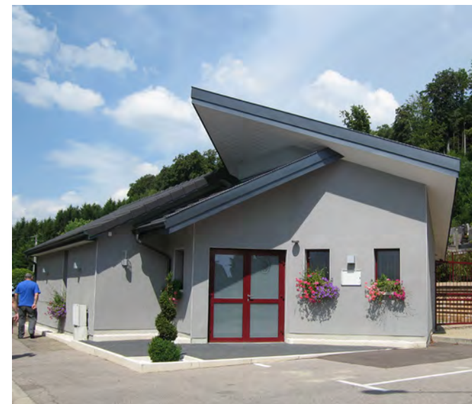
Chambre mortuaire du cimetière
