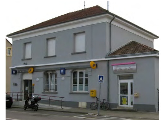
41 rue de la Gare, années 1930 : baies du RDC biseautées typiques du mouvement Art Déco
