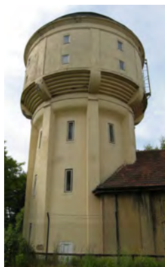
Château d'eau rappelant celui de la gare de Metz
