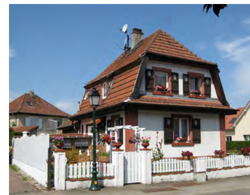
Exemplaire unique de petite maison d'ouvrier, construite au 49 rue de la Gare, en bordure de la cité des cheminots. Toiture complexe à coyaux, à brisis (de type toit à la Mansart) et à croupes (qui donnent l'impression que le toit n'a pas 2 pans mais 4)
