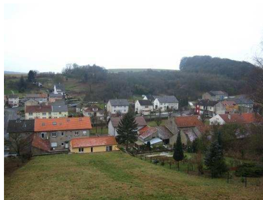
Point de vue sur le coteau Est depuis le château d'eau
