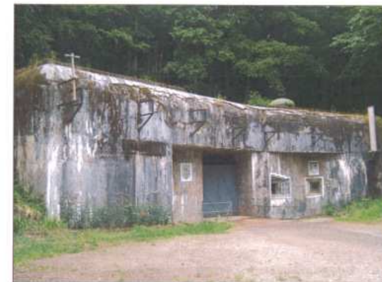
L'ouvrage d'artillerie du Michelsberg
