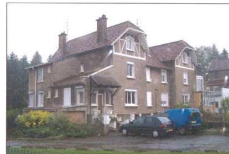
Les bâtisses à l'entrée Nord de Férage
