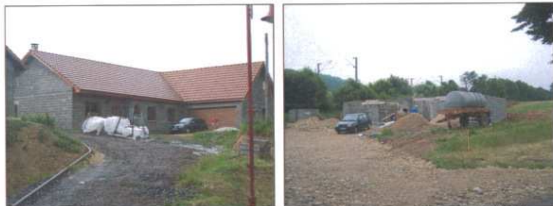
Habitation récente sur promontoire à Férange et maison en construction près de la voie ferrée à EBERSVILLER
