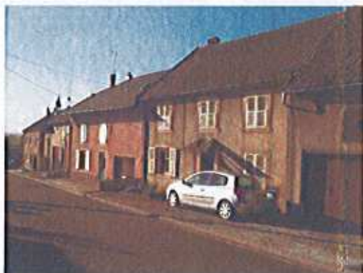
Bâtiments mitoyens de la rue des Tonneliers
